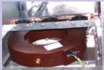
Il trasformatore di corrente toroidale The toroidal current transformer
